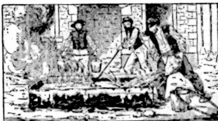
41. Ouvriers versant de l'eau sur de la chaux vive . Il se forme alors une pâte blanche : la chaux éteinte .
