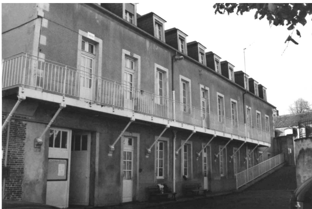
Aile refaite à la Restauration. Première école de filles.
