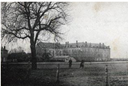
Ancien séminaire de Pignelin
