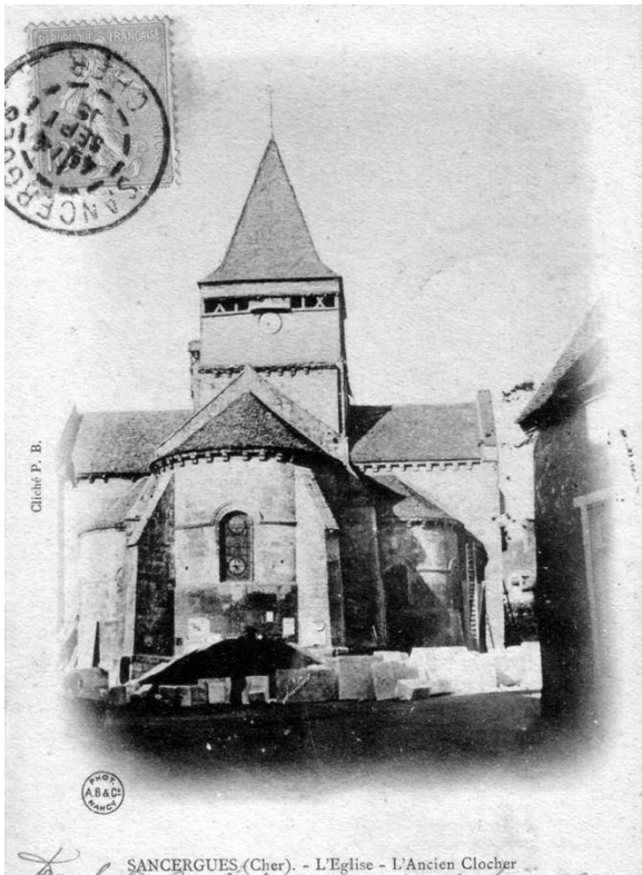
L'ancien clocher (Début de travaux avec les blocs de pierre)
